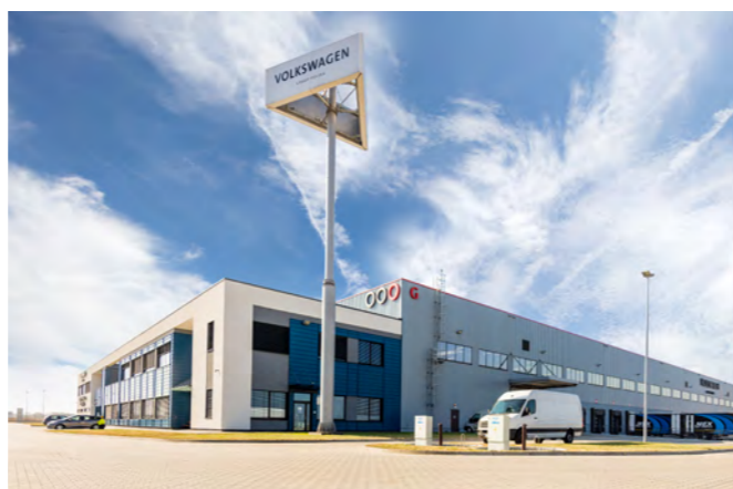
zdjęcie: Centrum logistyczne Volkswagen Group Polska w SEGRO Logistics Park Poznań, Komorniki
